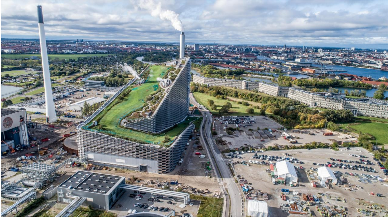
Planta WTE Amager Bakke (Copenhague, Dinamarca) Capacidad: 400,000 ton/año
