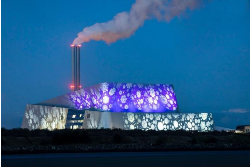
Planta WTE Covanta Dublin (Irlanda) Capacidad: 600,000 ton/año
